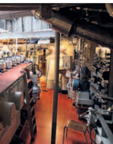
men ikke kraftig nok etter dagens krav.
